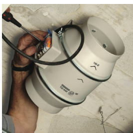
Sluit de ventilator aan.
